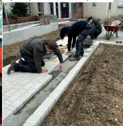
Des élèves de bac pro AP réalisent un chantier de pose de pavés devant l'entrée du lycée
